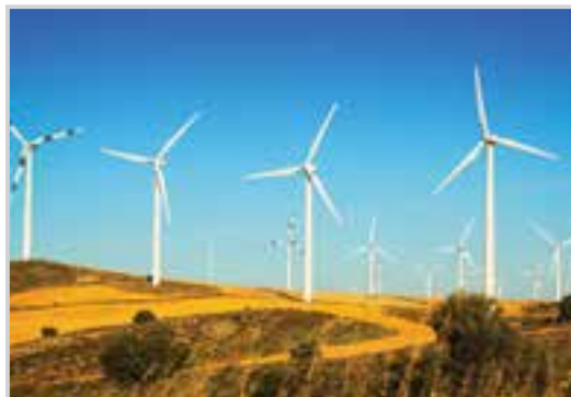
▲ Centrala e energjisë së erës
